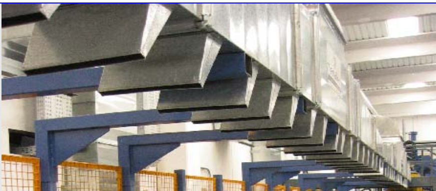
Abb. 8) Zusätzliche Luftdüsen über dem Auslauffisch
