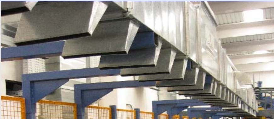
Fig. 8) Boquillas de aire adicionales para las mesas de salida de prensa
