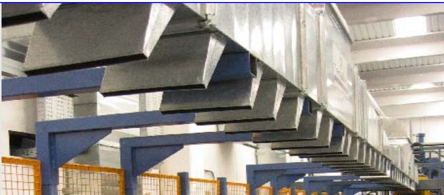
Im. 8) Refroidissement de l'air supplémentaire sur les tables
